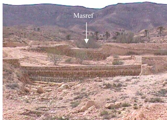
Figure 3.14 : Jisr avec déversoir type Masref
